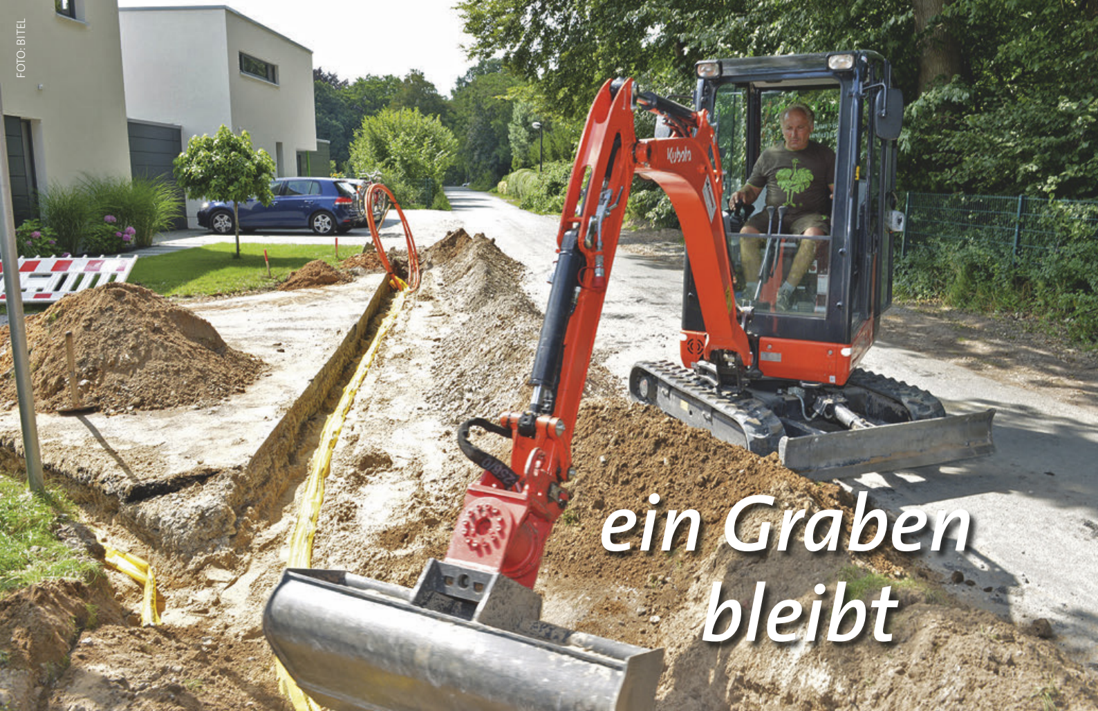
▲ Bei der Verlegung von Breitband-Datenkabeln werden Straßen und Gehwege durch Aufbrüche geschädigt
